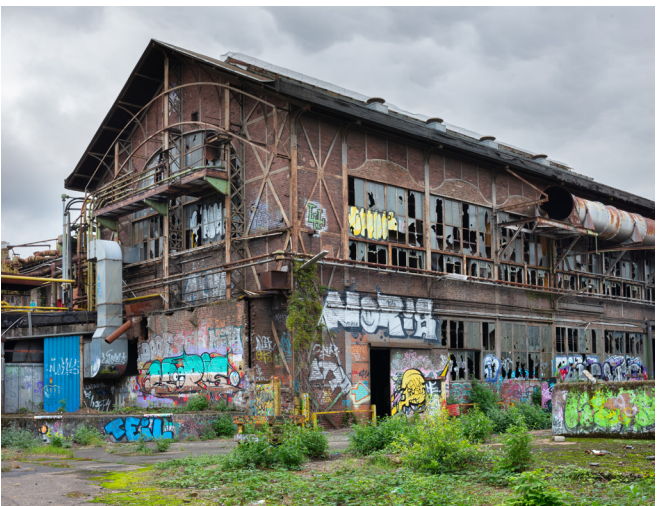
Denkmalgeschützte Möhringhalle aus dem Jahre 1902
